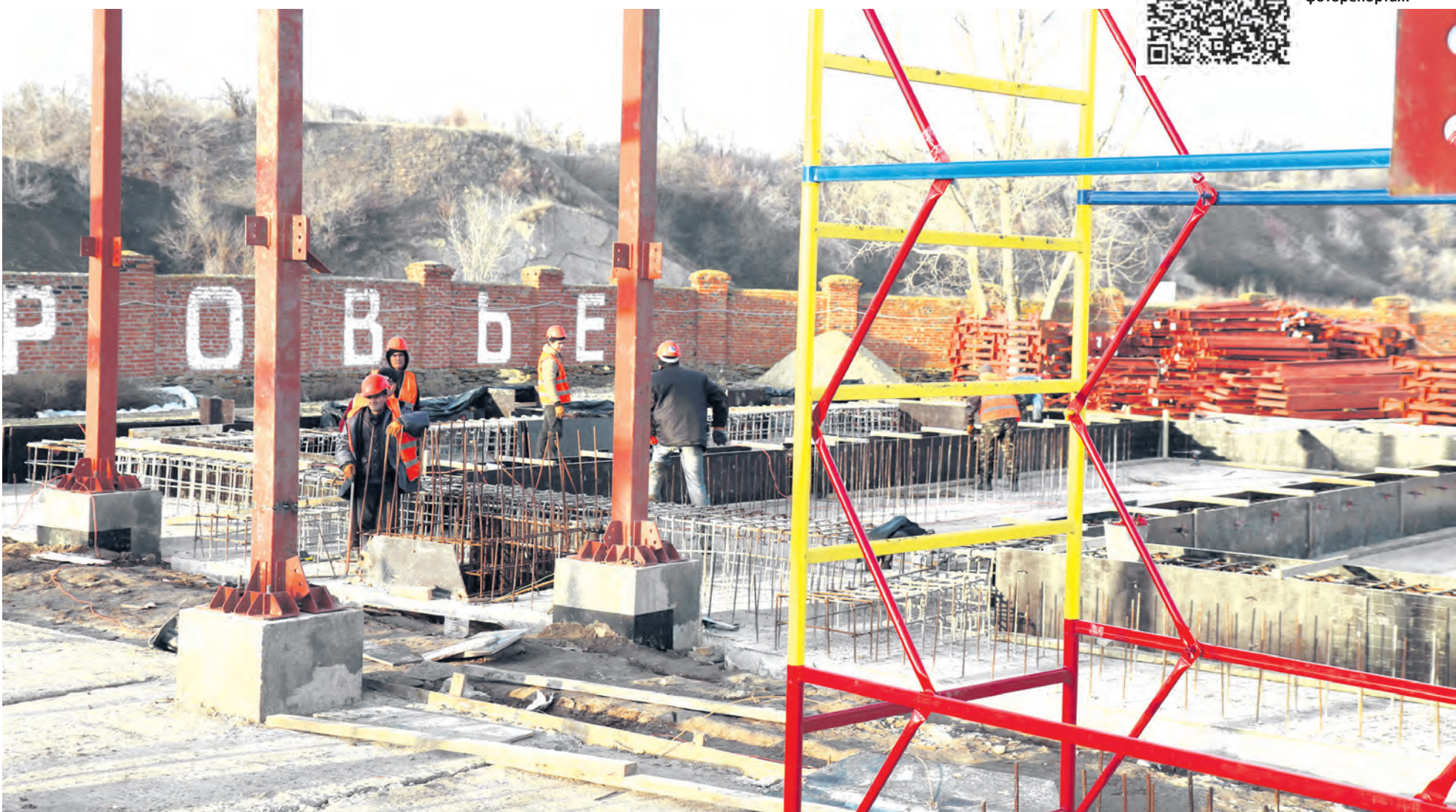
Сейчас основные работы на стройплощадке связаны с монтажом металлоконструкций каркаса здания административно-бытового комплекса и устройством финальной опалубки. Подрядчик - ООО ГК «Мегаполис» из Ростова-на-Дону. «Объект на улице Луговая будет состоять из двух корпусов: в одном будет располагаться непосредственно чаша бассейна, а второй – административно-бытовой. В самом бассейне будет шесть 25-метровых плавательных дорожек. Одновременно здесь смогут заниматься 36 человек», – пояснил заместитель главы администрации района по вопросам строительства, архитектуры и промышленности Сергей Кружилин. Фото Н. Николаевой
